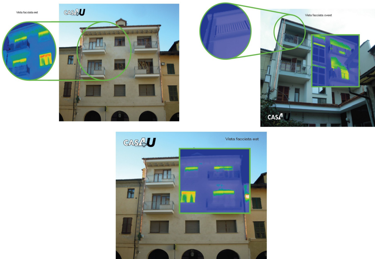
esempi di termografia su edificio riqualificato con Casa+
